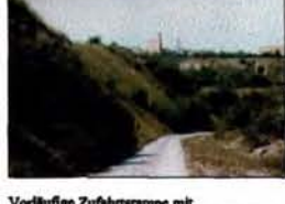
Vorläufige Zufahrtstrasse mit natürlich ansteigender Kalksteinoberfläche als Sukzessionsgesellschaft, die bei späterer Expansion nach Westen zur Realisierung des großflächigen Feldfrüherbiotops zurückgebaut wird (Steinbruch)
